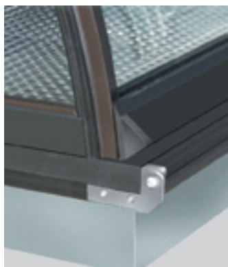
Scheibenanschlag durch Stützkloben
